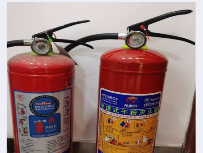
及时罐装打压，每月点检一次灭火器
