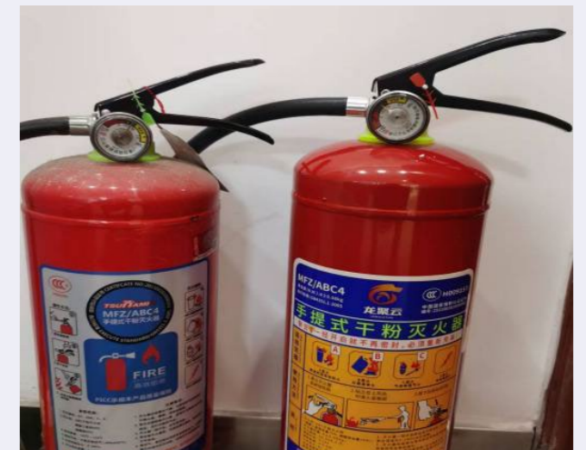
及时罐装打压，每月点检一次灭火器
